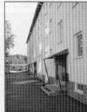
Härmälänsaarenkatu 3, saneerattu vuokrakohde
