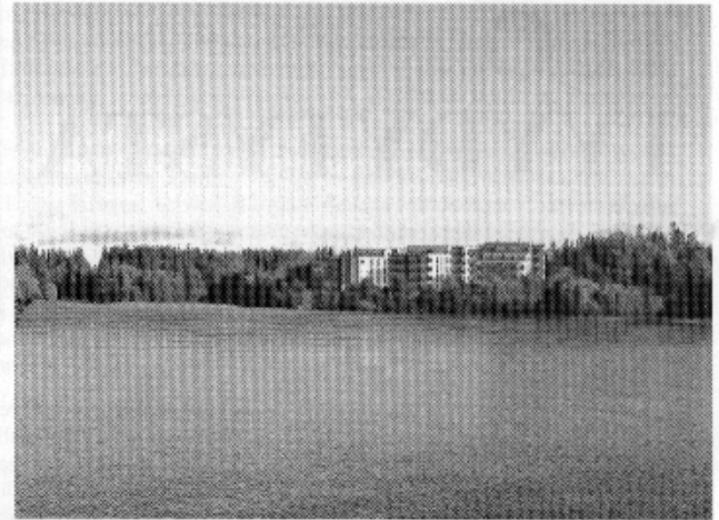
As Oy Tampereen Jalavaranta kuvan taloista äärimmäisenä oikealla
